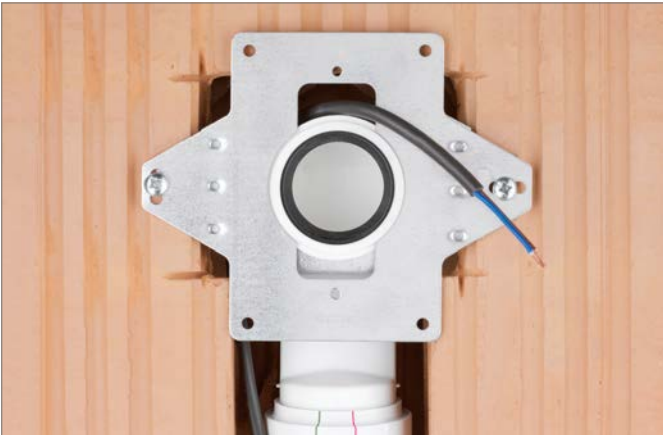
Şek. 5-3 Montajı tamamlanmış montaj çerçevesi
