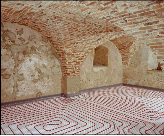
Şek. 3-22 REHAU Noppenplatte vario sistemi
