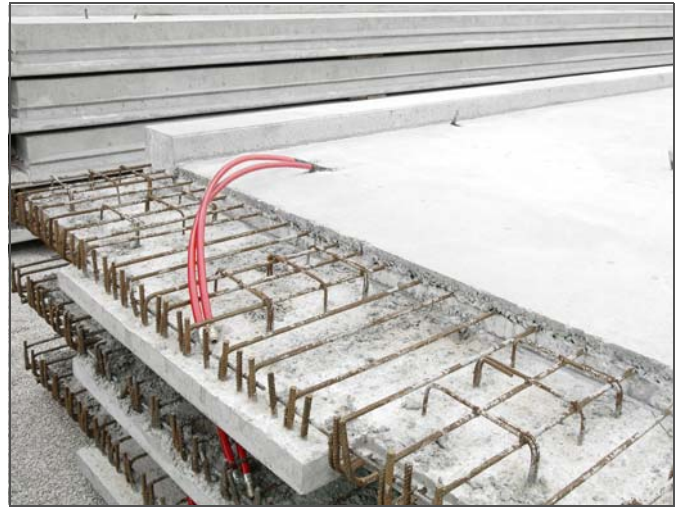
Şek. 11-4 Yarı işlenmiş parçada REHAU BKT
