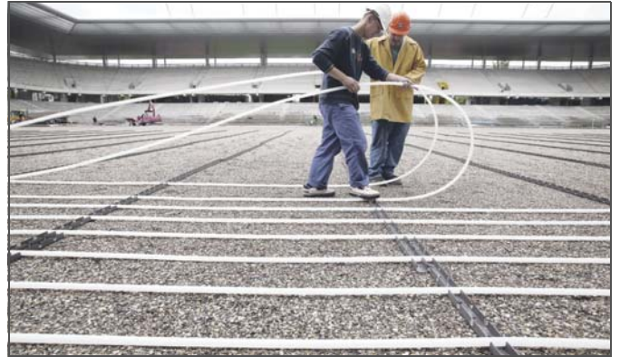
Şek. 16-3 Isıtma borularının döşenmesi
