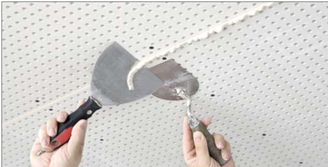
Şek. 4-25 Sertleşen harcın kazınarak çıkarılması
