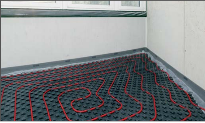
Şek. 3-11 Alt kısmı 30-2 basma sesi yalıtımlı REHAU Noppenplatte Varionova sistemi
