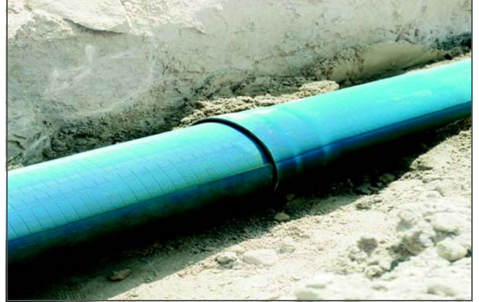
Şek. 16-2 Oyun sahasına drenaj döşenmesi
