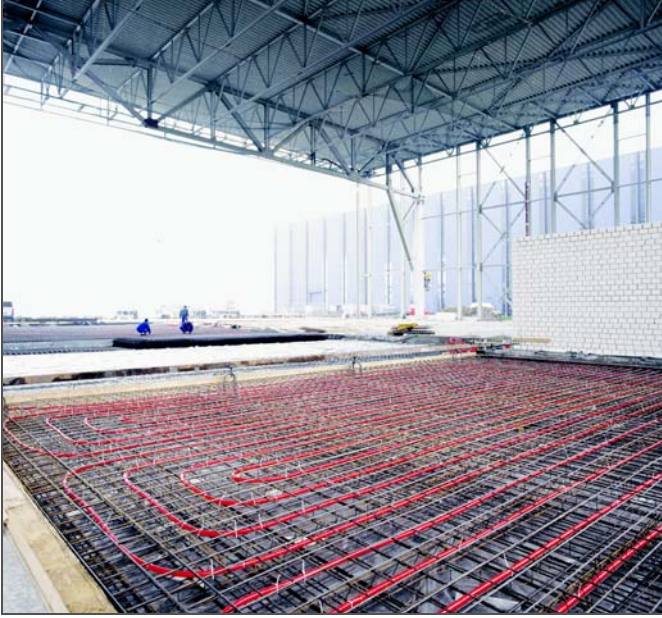
Şek. 12-1 Endüstriyel döşemeden ısıtma
