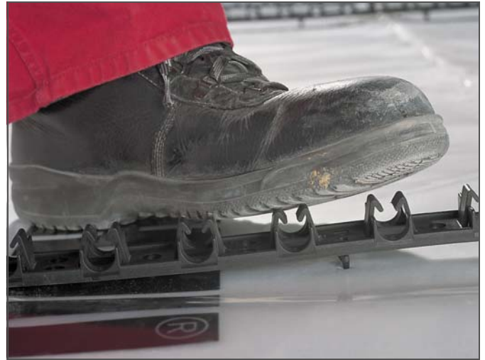
Şek. 3-39 REHAU RAUFIX lamayı zemin yapısının içine bastırın
