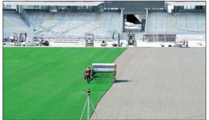
Şek. 16-4 Rulo çimin döşenmesi
