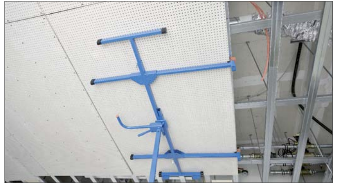
Şek. 4-21 Tavan plakalarının doğru konumlandırılması için palet kaldırıcısı
