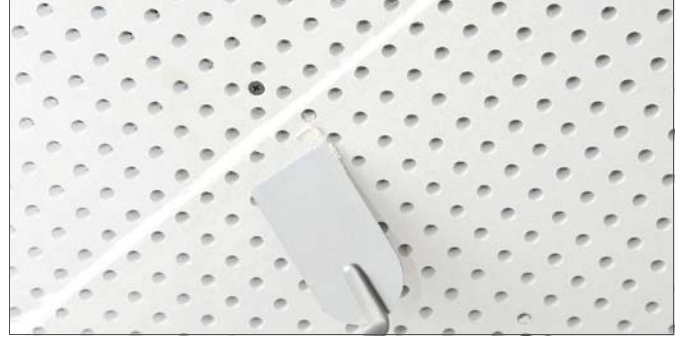
Şek. 4-26 Vida başlarına harç atılması
