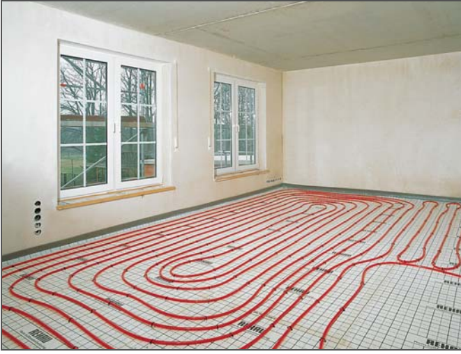
Şek. 3-27 REHAU çivileme sistemi
