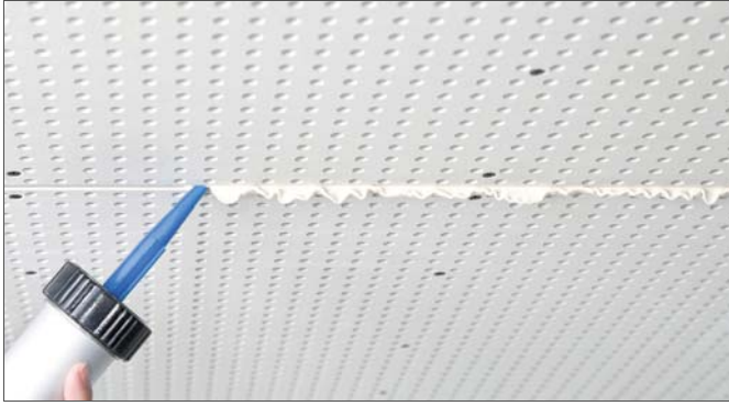
Şek. 4-24 Tüm plaka kalınlığı üzerinden derzin 20 mm olarak tamamen doldurulması
