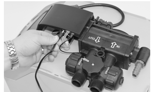
Şekil 15: Transformatör Güç Kablosunu Bağlayın
